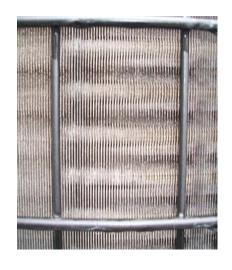
左記は、データセンター(大阪府)で水道水を散水した結果、フィンヘスケールが付着した状況です。アルミフィンがスケールによって部分的に閉塞状態になっています。
